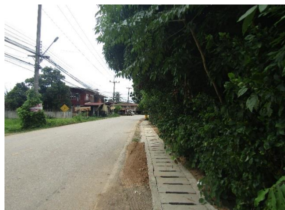
ก่อสร้างถนนคอนกรีตเสริมเหล็ก / ก่อสร้างรางระบายน้ำคอนกรีตเสริมเหล็ก
